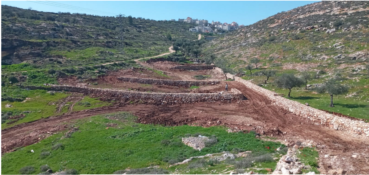
Creazione dei muretti di sostegno
